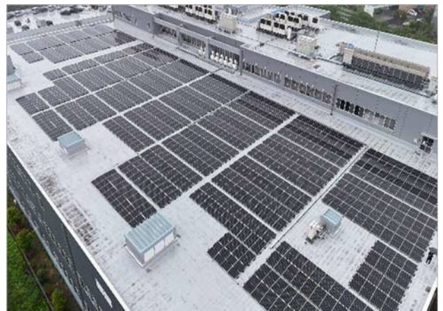
太陽光パネル設置状況
