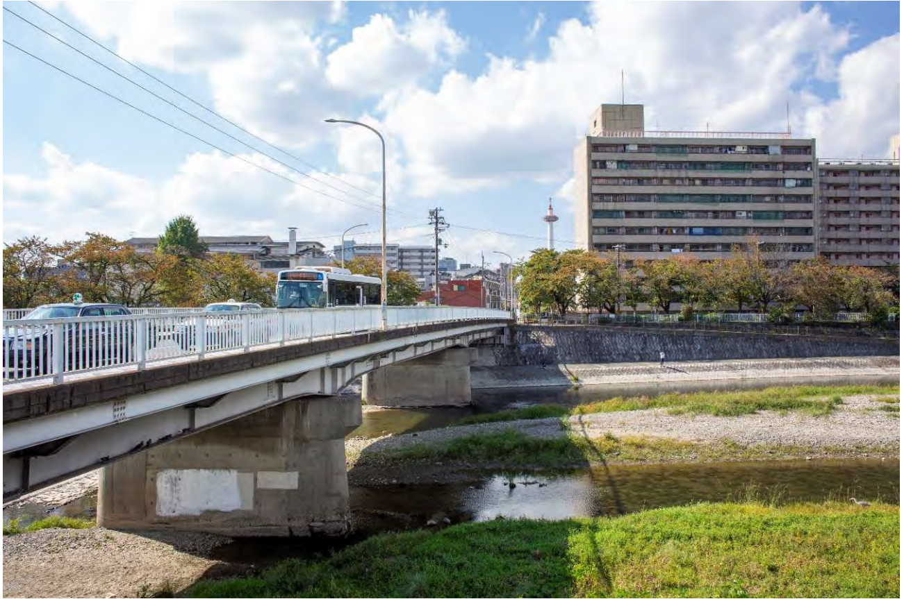
図 7.6-3(1) 塩小路橋からの景観（現況）
