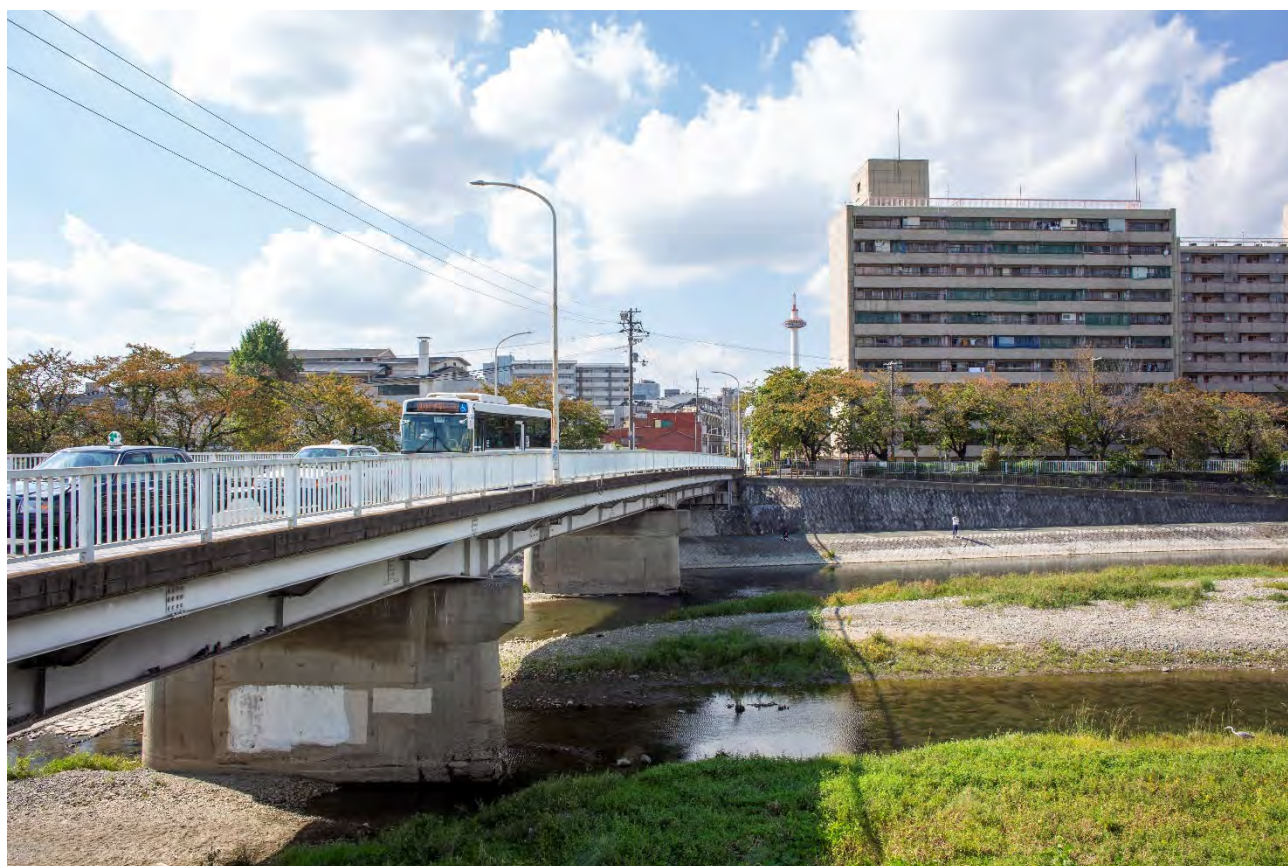
図 3.3.2-3 (1) 塩小路橋からの景観（現況）
